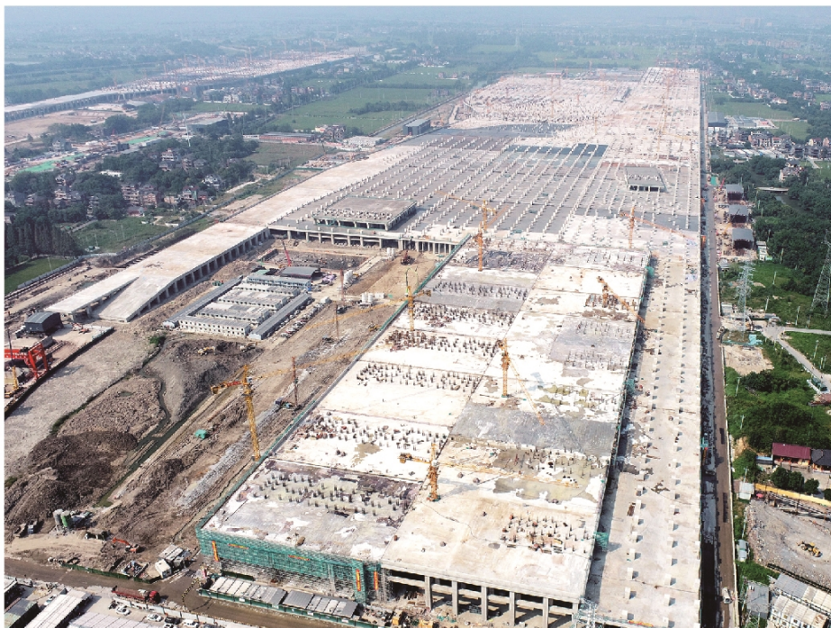
杭州机场轨道快线前车辆基地1标项目（杭州公司承建）
