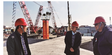
2021年12月23日，李剑彤总栽莅临湖州南浔隧道工程检查指导。
