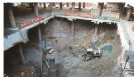
武汉洪山广场地铁站暗挖施工照片
