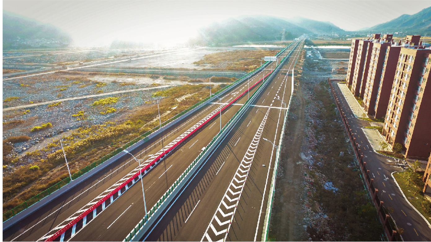
宁波象山石浦高速公路新桥连接线PPP工程 (总承包公司承建)
