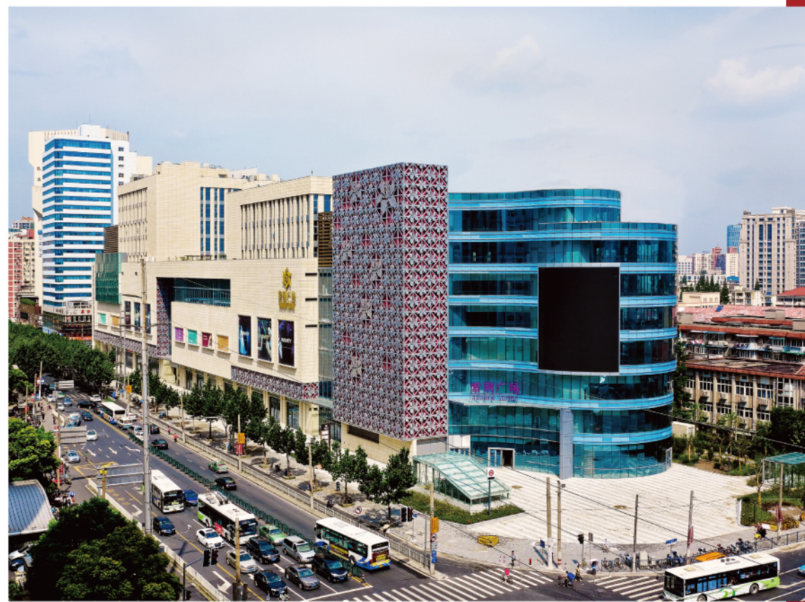
上海市杨浦区地铁8号线江浦路站紫荆广场（公司第五项经部承建）
